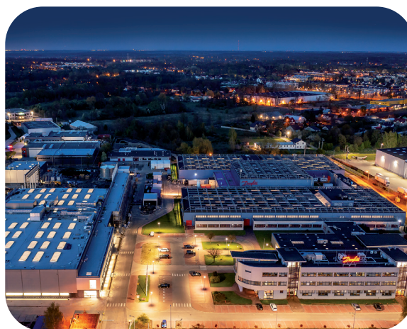
Kompleks biurowo-produkcyjny Danfoss Poland w Grodzisku Mazowieckim.
