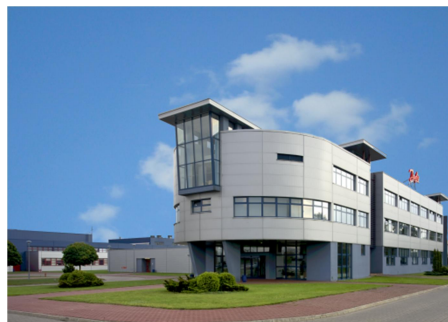
Kompleks biurowo-produkcyjny Danfoss Poland Sp. z o.o. w Grodzisku Mazowieckim.
