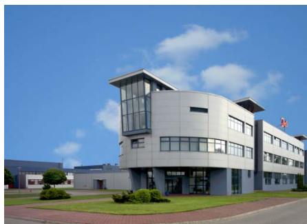
Kompleks biurowo-produkcyjny Danfoss Sp. z o.o. w Grodzisku Mazowieckim.
